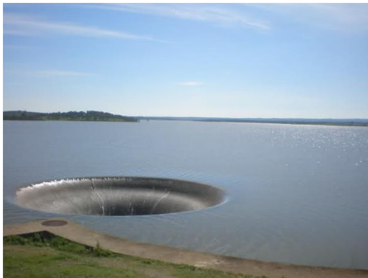
Figura 9 - Barragem do Monte da Rocha descarregador tipo Tulipa. (METEOPT. Disponível em: < http://www.meteopt.com/forum/seguimento-meteorologico/seguimento-rios-albufeiras-2010-a-4099-5.html >. Acesso em jun. 2014)
