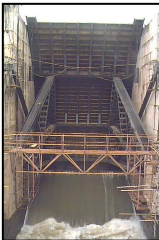
Figura 7 - Esquema de funcionamento de comporta do tipo Setor ou Segmentado. (Noções de Geração de Energia Elétrica. Três Irmãos, 2006, p. 16)
